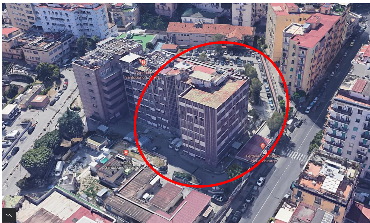
Inquadramento – vista satellitare del Padiglione Santobono oggetto dell'adeguamento sismico
